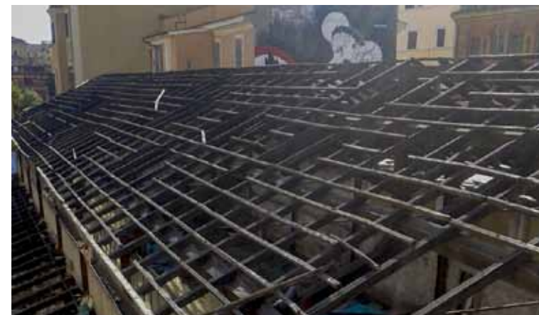
Giugno 2013 _ Le capriate ormai distrutte della vecchia Fonderia
